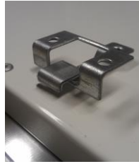
Detail eingehängte Deckenhalter
