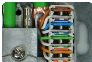
Abb.: Überstehende Adern abgeschnitten
