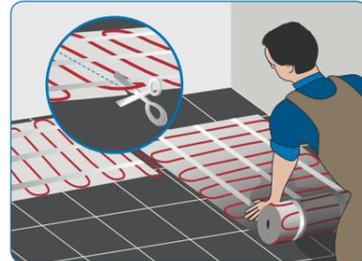
5) Rollen Sie die Matte aus. Schneiden und drehen Sie die Matte, sobald Sie auf Wände oder Hindernisse stoßen. **ZERSCHNEIDEN SIE NICHT DAS KABEL.** Mindestabstand 2 cm zwischen zwei Heizleitungen.
