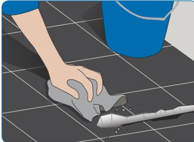
4) Reinigen Sie den Unterboden zum Schutz der Leitung während der Installation und zur Gewährleistung maximaler Haftung der Matte.
