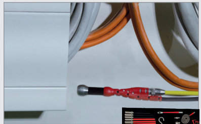
Axlar och golvkanaler
