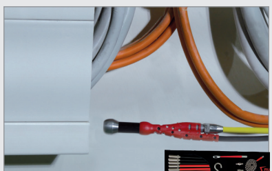
Jaški in kanali pod tlemi
