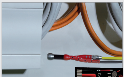
Szachty i kanały podpodłogowe
