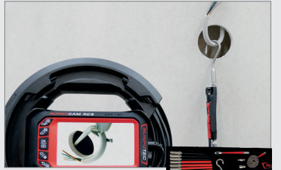
Boşluklu duvar incelemesi
